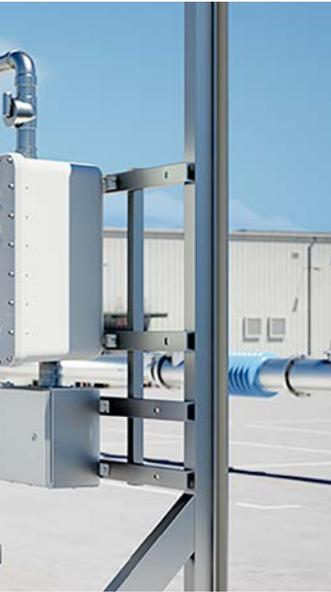
Ex d-Gehäuse sind flammendurchschlagsicher, das heisst, sie schliessen eine Explosion im Inneren ein und verhindern deren Ausbreitung nach aussen. Der Flammenweg in Ex d-Gehäusen kühlt Funken, Flammen und heisse Gase ab und verhindert so die Entzündung der umgebenden explosionsfähigen Atmosphäre.
